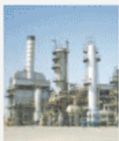
(آ) نمای بیرونی برج تقطیر در پالایشگاه (ب) در برج تقطیر با گرما دادن به نفت خام، اجزای آن را جدا می‌کنند.
