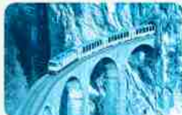
احداث تونل و پل برای عبور قطار در نواحی کوهستانی و نرسنگیز - سوئیس
